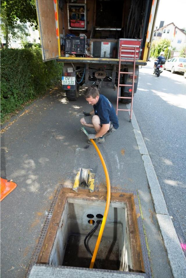
**Schacht + Verlegung von Leerrohren (Quelle Stadtwerke Sindelfingen)**
